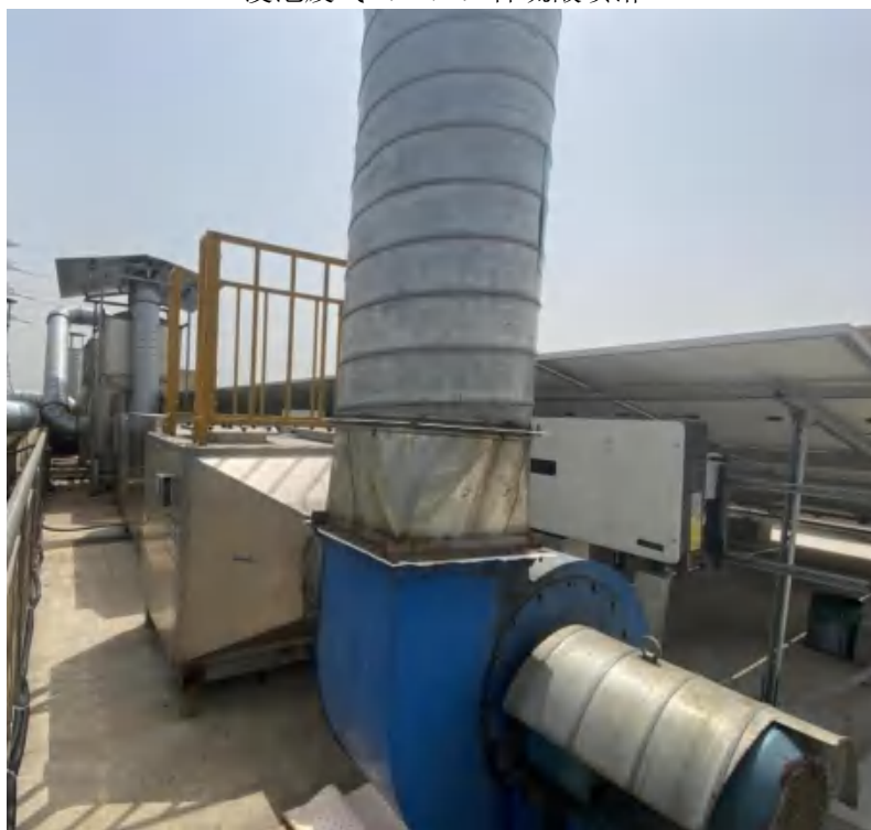
脱脂废气废气处理设施（3#）：喷淋+油水分离+光催化氧化+活性炭吸附
