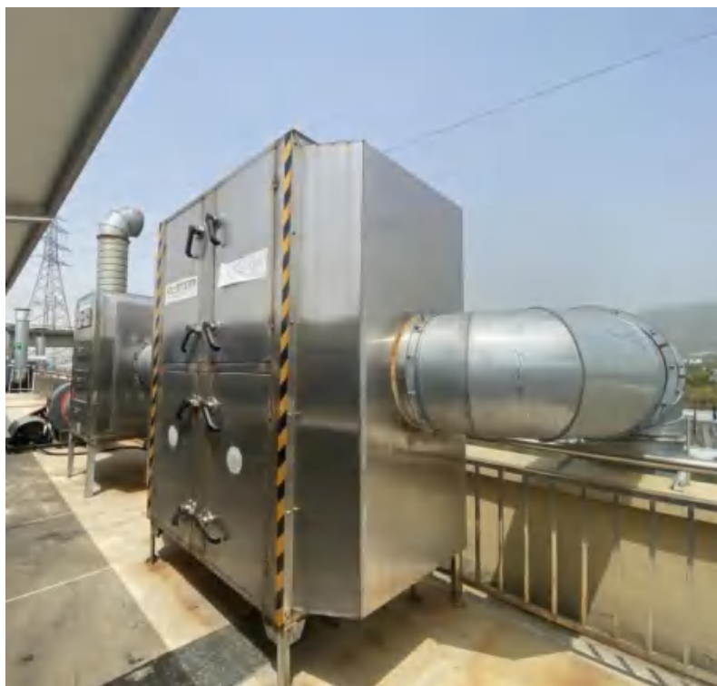
干燥烧结废气、造粒烧结废气处理设施（4#）：过滤棉+二级活性炭
