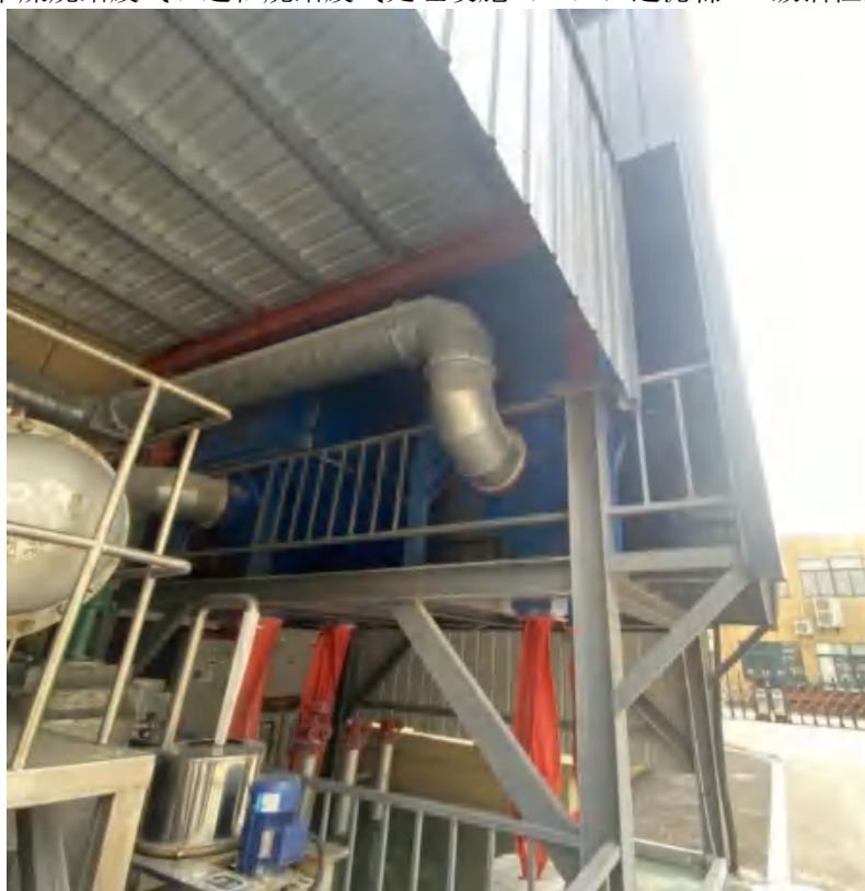
磨粉、筛粉、混料、造粒及投料粉尘（5#）：布袋除尘
