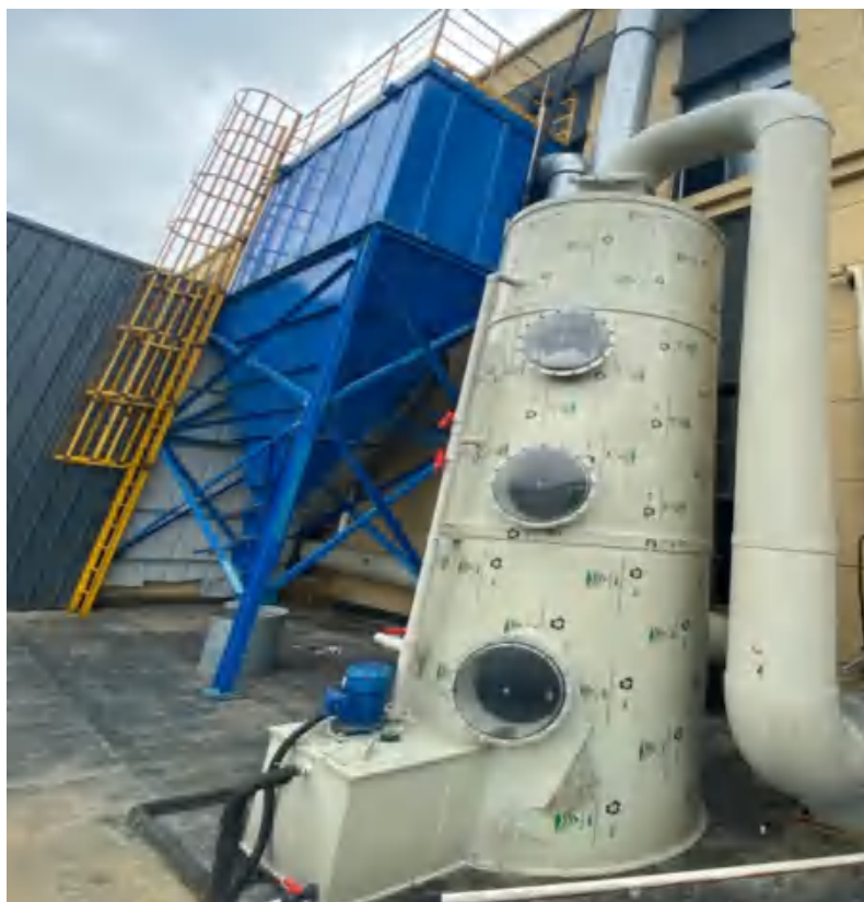
浸泡废气（2#）：稀硫酸喷淋
